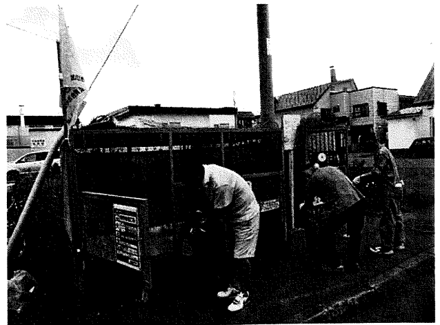
ゴミステーション塗装補修
